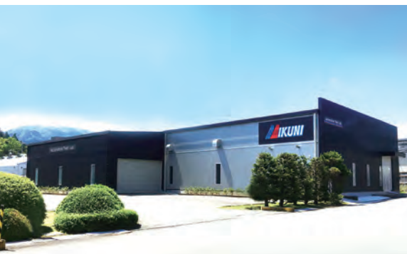
四輪車試験施設「Lab.0」（小田原事業場内）
