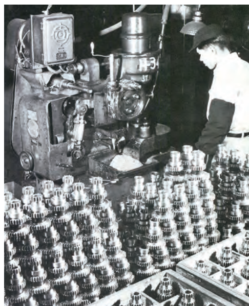
戦後のトランスミッションの加工風景
